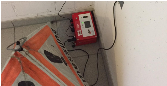
Installation Erschütterungs-Messgerät zur permanenten Überwachung
